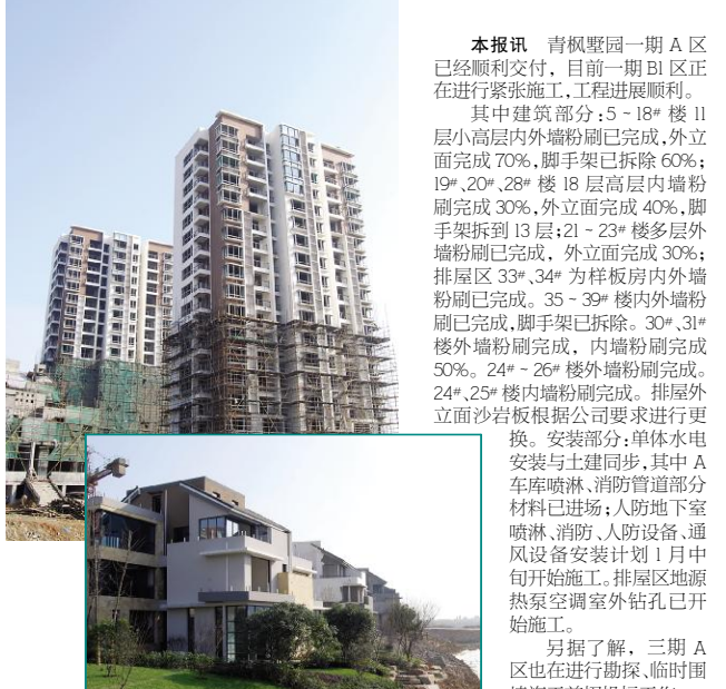
青枫墅园一期 A 区已经顺利交付，目前一期 B1 区正在进行紧张施工，工程进展顺利。其中建筑部分：5-18#楼11层小高层内外墙粉刷已完成，外立面完成70%，脚手架已拆除60%；19#、20#、28#楼18层高层内墙粉刷完成30%，外立面完成40%，脚手架拆到13层；21-23#楼多层外墙面粉刷已完成，外立面完成30%；排屋区33#、34#为样板房内外墙粉刷已完成。35-39#楼内外墙粉刷已完成，脚手架已拆除。30#、31#楼外墙面粉刷完成，内墙粉刷完成50%。24#-26#楼外墙面粉刷完成。24#、25#楼内墙粉刷完成。排屋外立面沙岩板根据客户要求进行调整。安装工程：单体水电安装与土建同步，其中A车库喷淋、消防管道部分材料已进场；人防地下室喷淋、消防、人防设备、通风设备安装计划1月中旬开始施工。排屋区地源热泵空调室外钻孔已开始施工。另据了解，三期A区也在进行勘探、临时围堰施工前招投标工作。
